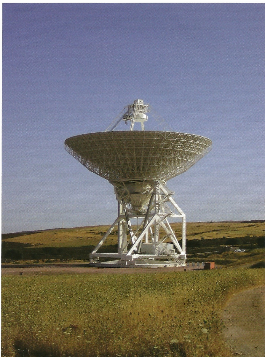
Il Sardinia Radio Telescope (SRT) installato in località San Basilio, presso Cagliari, vanta un'antenna di ben 64 metri di diametro.
