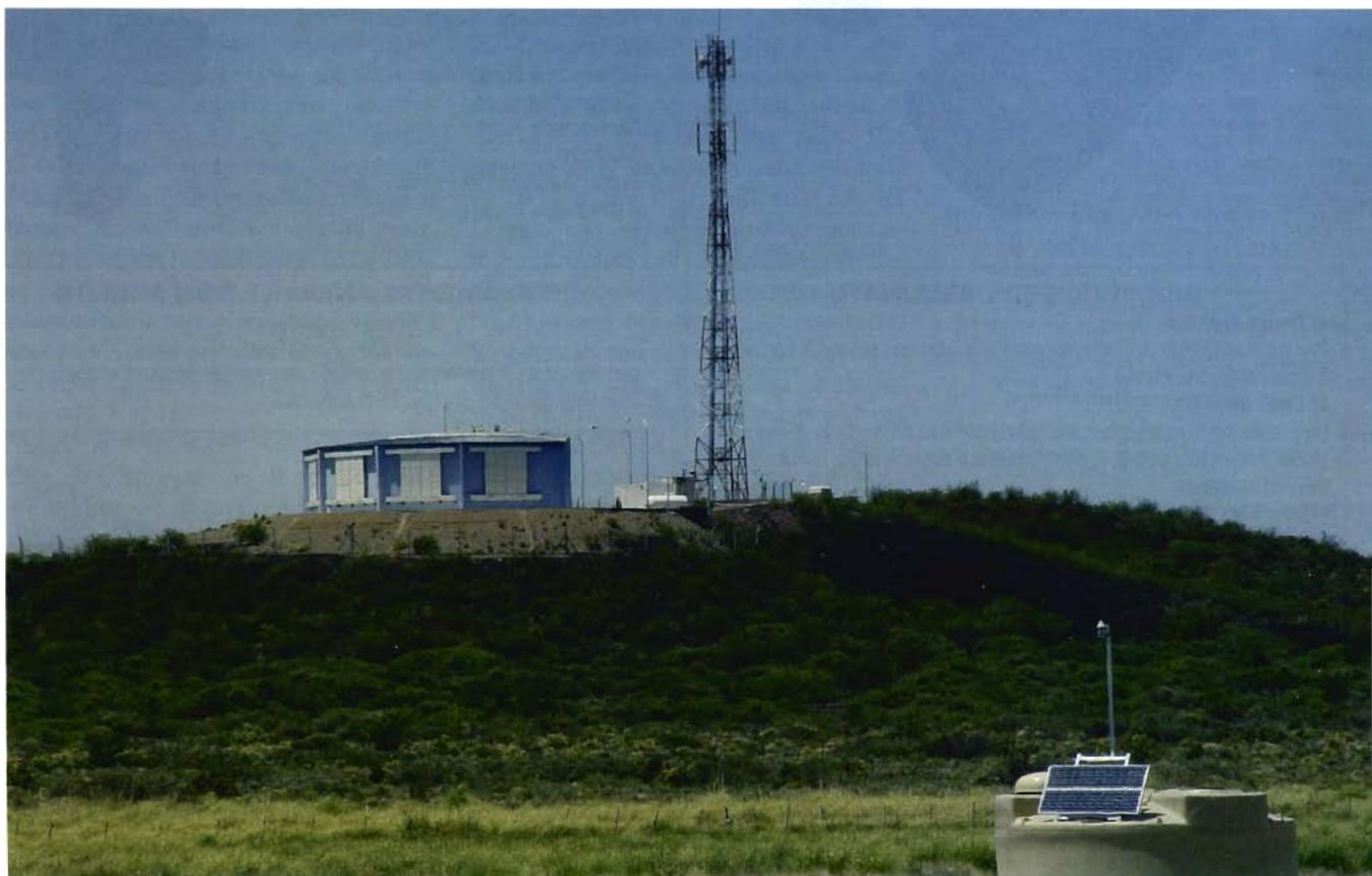
*L'Osservatorio Auger dispone di quattro telescopi per osservare la luce di fluorescenza (come quello sulla collina) e di 1600 rivelatori di superficie (come quello in basso).*
